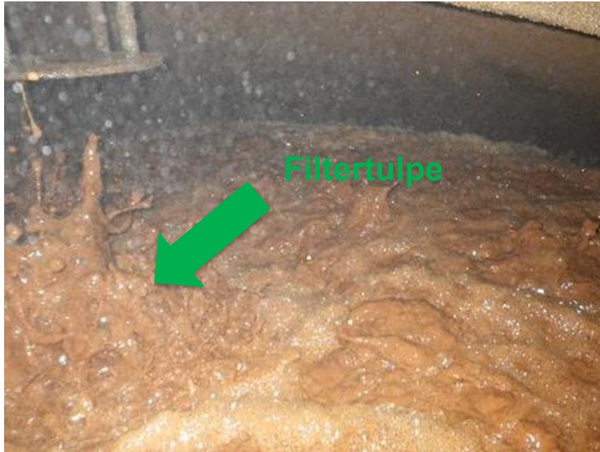
Kombinierte Luft- / Wasserspülung
